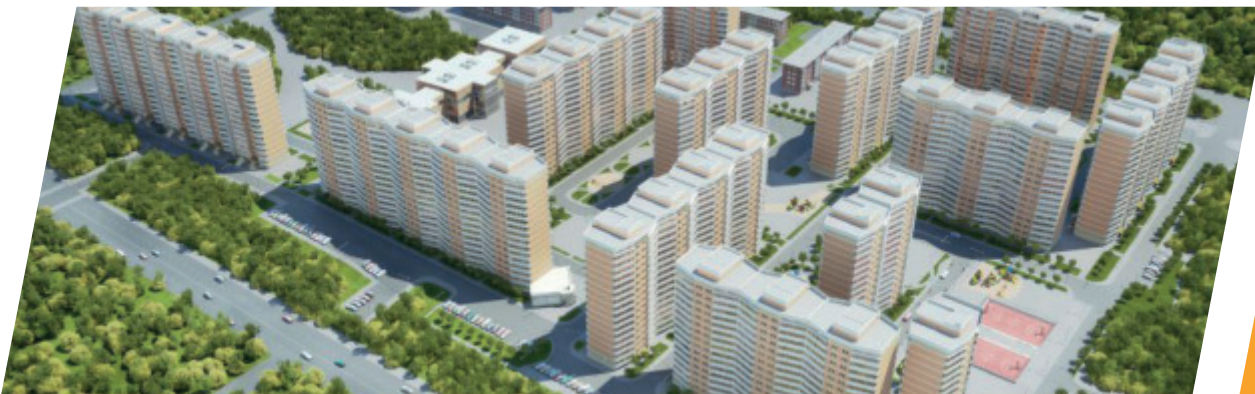
ЖК «Народный»: монтаж инженерных систем здания
